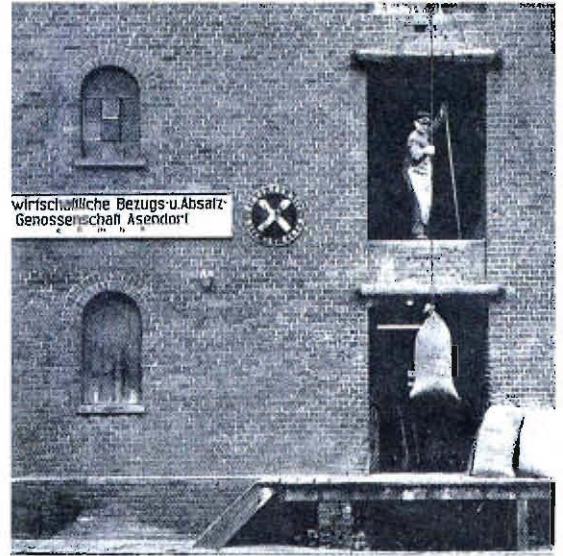
Sackaufzug der RWG in Betrieb
