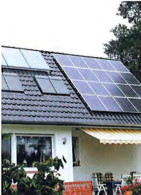
Solarmodule für Warmwasser und Strom
