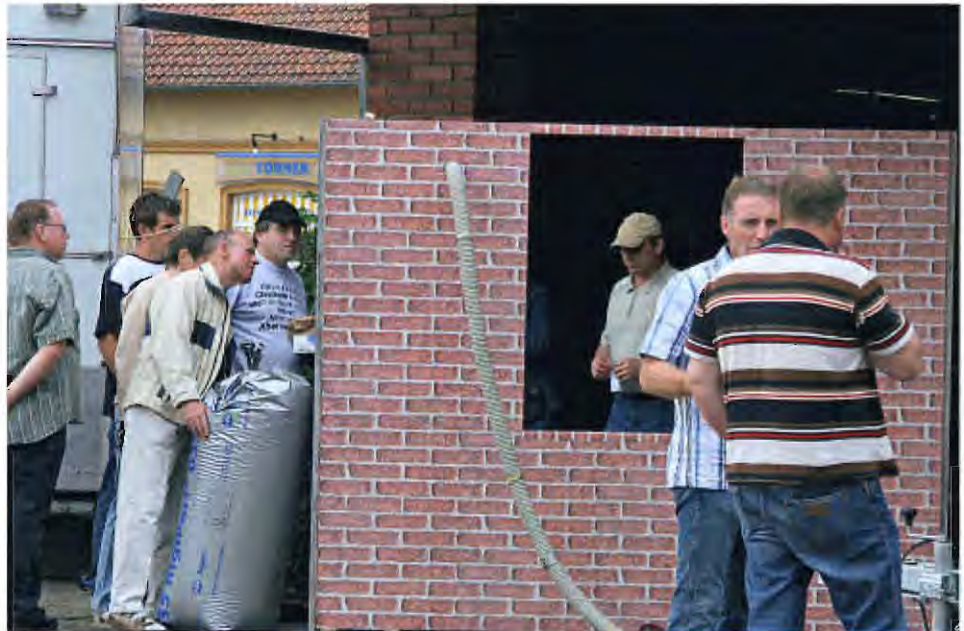
Wie verteilt sich das eingeblasene Dämmmaterial?
