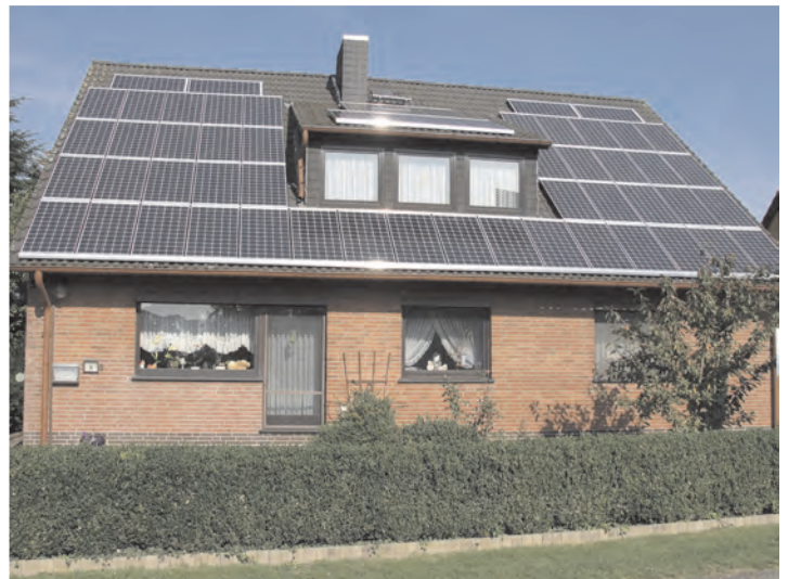
2. Tag: Montage der Module / Fertigstellung der Anlage
