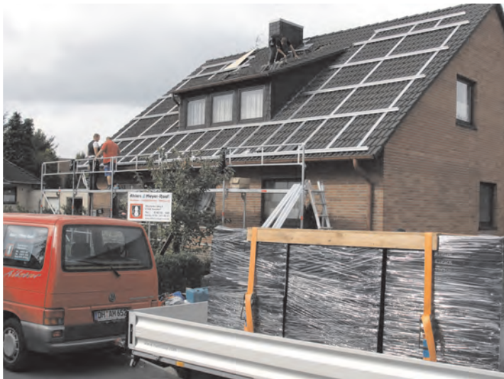
1. Tag: Aufbau der Unterkonstruktion
