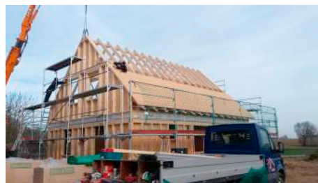
Rohbau EFH in Holzrahmenbauweise
