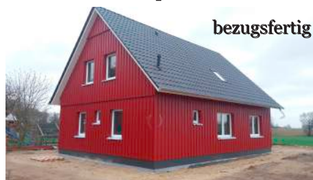
Rohbau EFH in Holzrahmenbauweise
