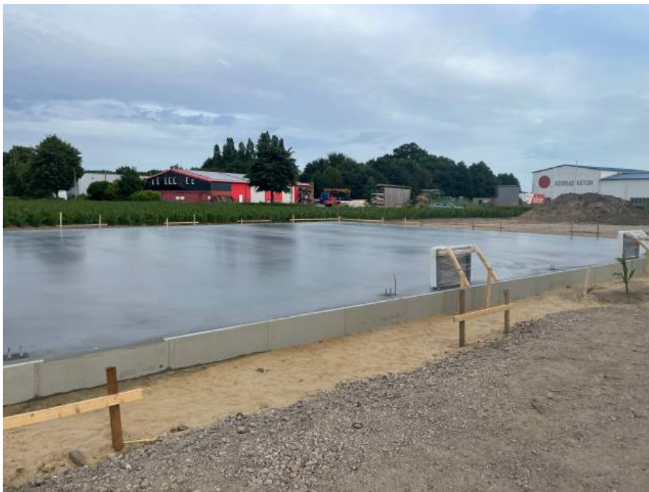
Die Bodenplatte der Firma TK-Robotik mit Blick auf das Betonwerk und die Dachdeckerei Logemann im Gewerbegebiet
